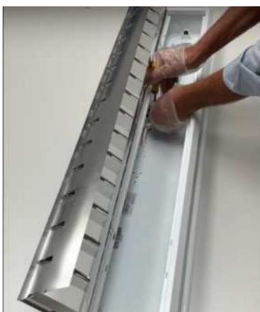
Entfernen Sie die alten Kabelverbindungen, Vorschaltgeräte Fassungen und ggf. andere alte Komponenten und entsorgen Sie diese fachgerecht.
