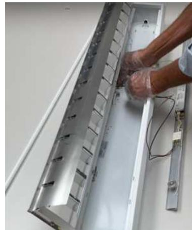
Verbinden Sie die MAX Lichteinsatzleuchte mit neuen Kabeln und der Stromversorgung der Leuchte (230V).
