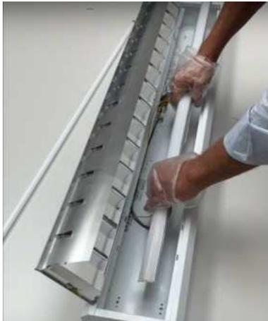
Montieren Sie nun die MAX mittels der am MAX-Gehäuse befindlichen Magnete (ggf. verwenden Sie die mitgelieferten Montageklammern) und vergewissern Sie sich des korrekten Haltes.
